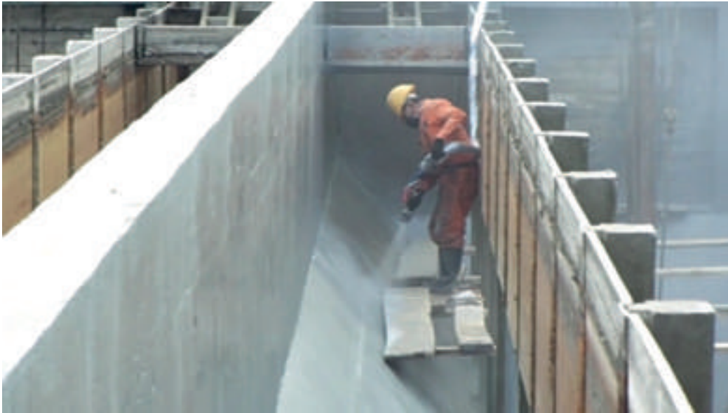
Aplicación poliurea mantenimiento PTAR SALITRE.
